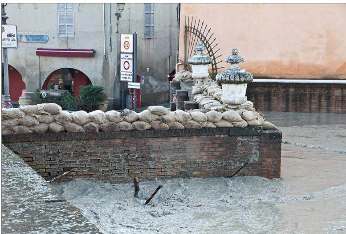
Figura 3-13: Sacchettatura sul muro in sponda destra, a monte del ponte di piazza Garibaldi (ore 15:00 del 25 dicembre 2009) (Foto P. Mignosa).
